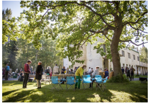
Lyhytaaltoaseman seinän rappausta paikataan syksyllä 2020. Kuva: Niilo Rinne
